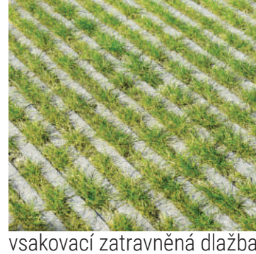
vsakovací zatravněná dlažba na parkovacích stáních
